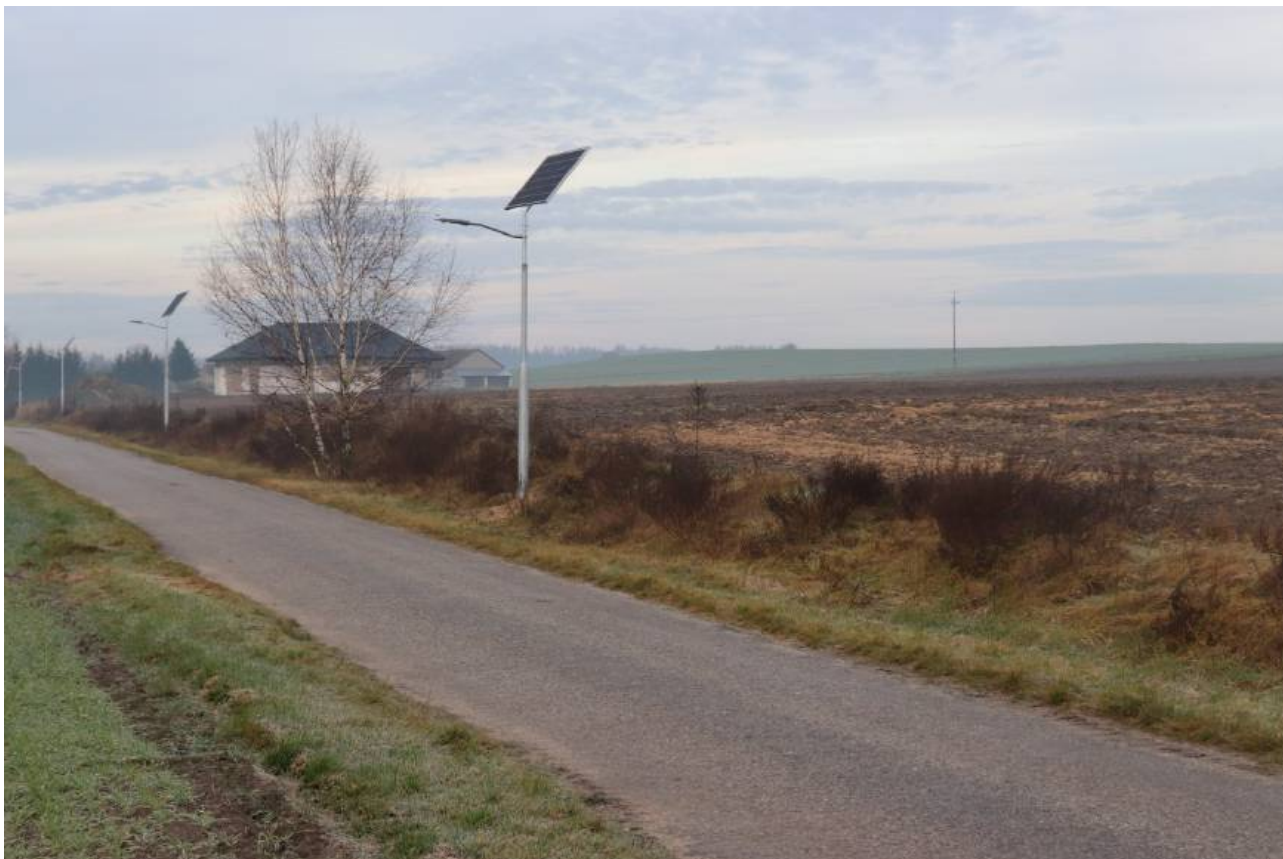
Budowa oświetlenia solarnego w miejscowości Dęba
