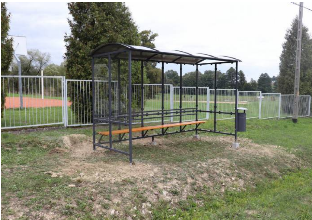
Budowa wiaty przystankowej w miejscowości Stobnica
