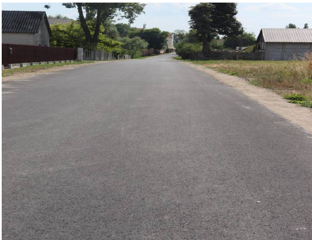
Przebudowa drogi Ręczno ul. Cmentarna
