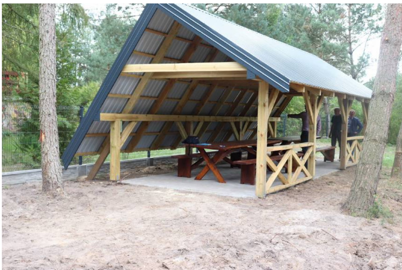
„Budowa wiaty rekreacyjnej z wyposażeniem dla sołectwa Łęg Ręczyński”
