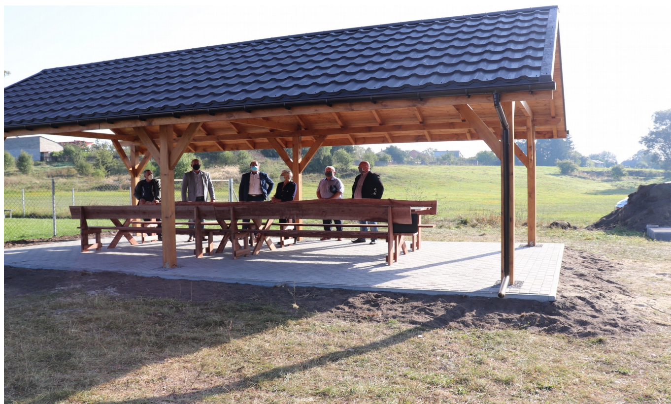
„Budowa wiaty rekreacyjnej z wyposażeniem dla sołectwa Stobnica”
