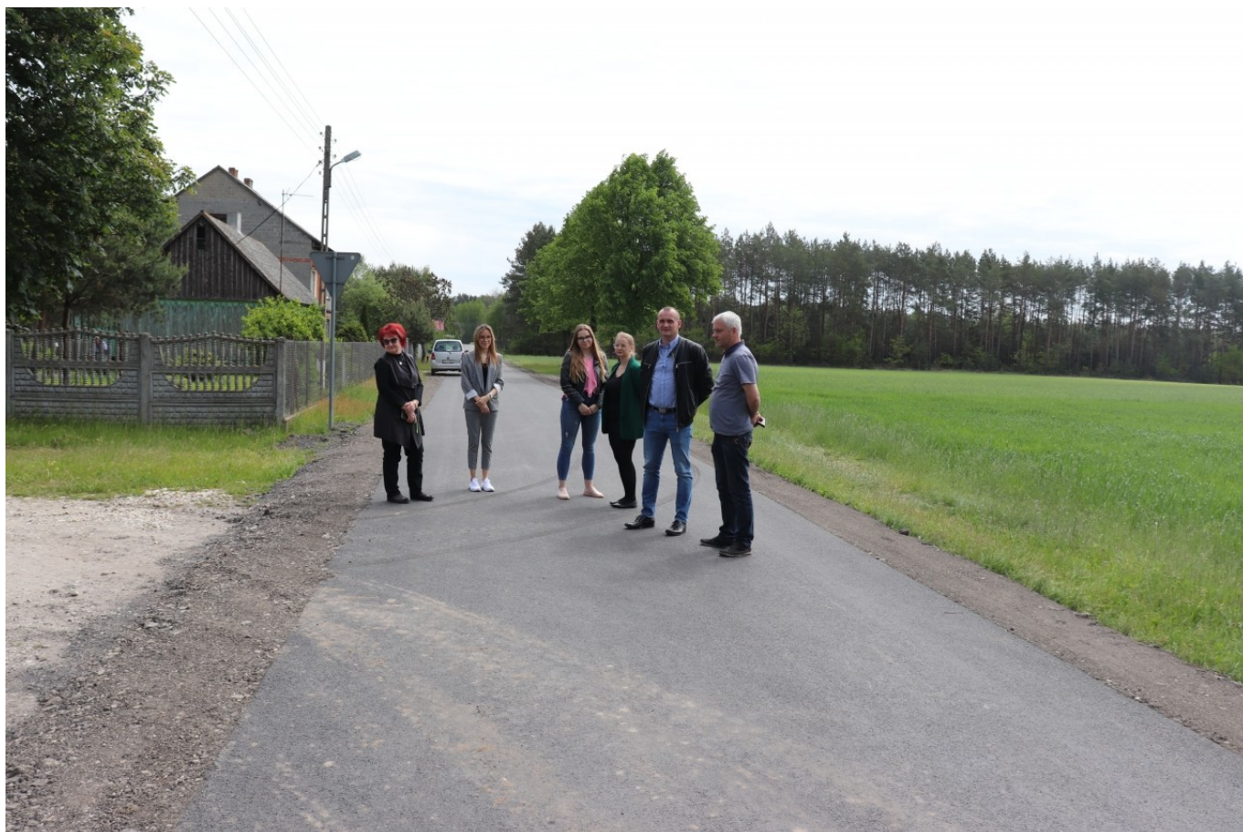
Przebudowa drogi gminnej nr 110311E Ręczno-Ignaców Poduchowny
